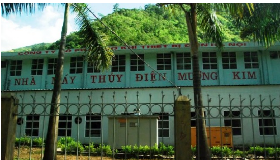
Nhà máy vận hành thủy điện Mường Kim
